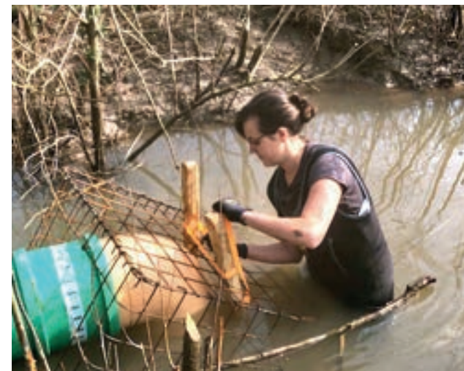
Viviane Magistra beim Einbau einer Drainage
